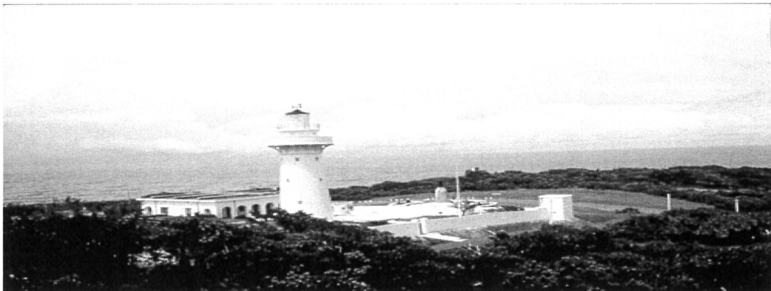
— 静岡県・ガランピ灯台 —
